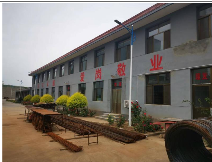
现有工程办公楼
