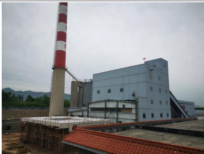
原有工程锅炉房及 80m 高烟囱
