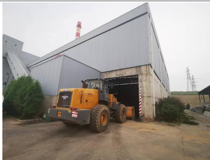
原有工程全封闭储煤库
