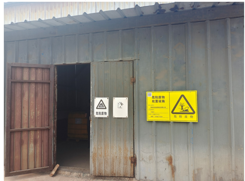
企业危废暂存间
