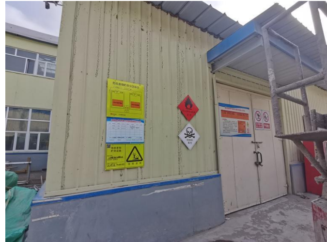
现有危险废物贮存库
