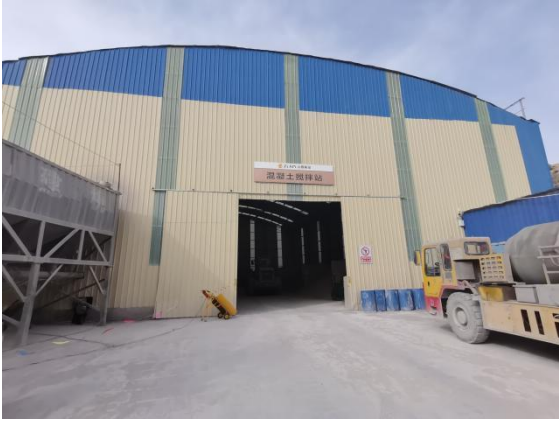
搅拌站封闭式厂房
