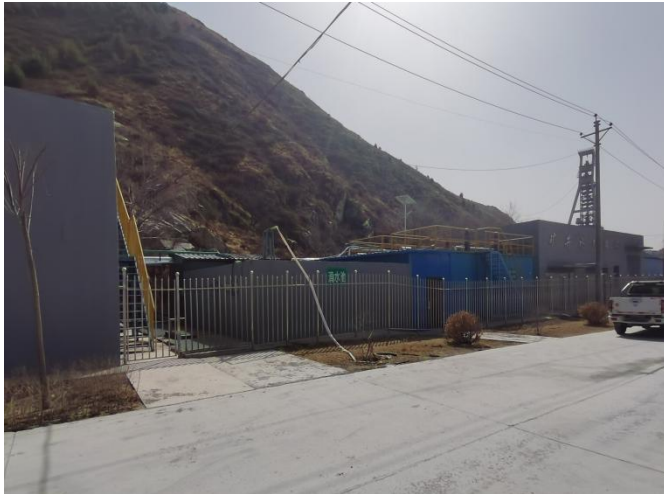
现有矿井水处理站
